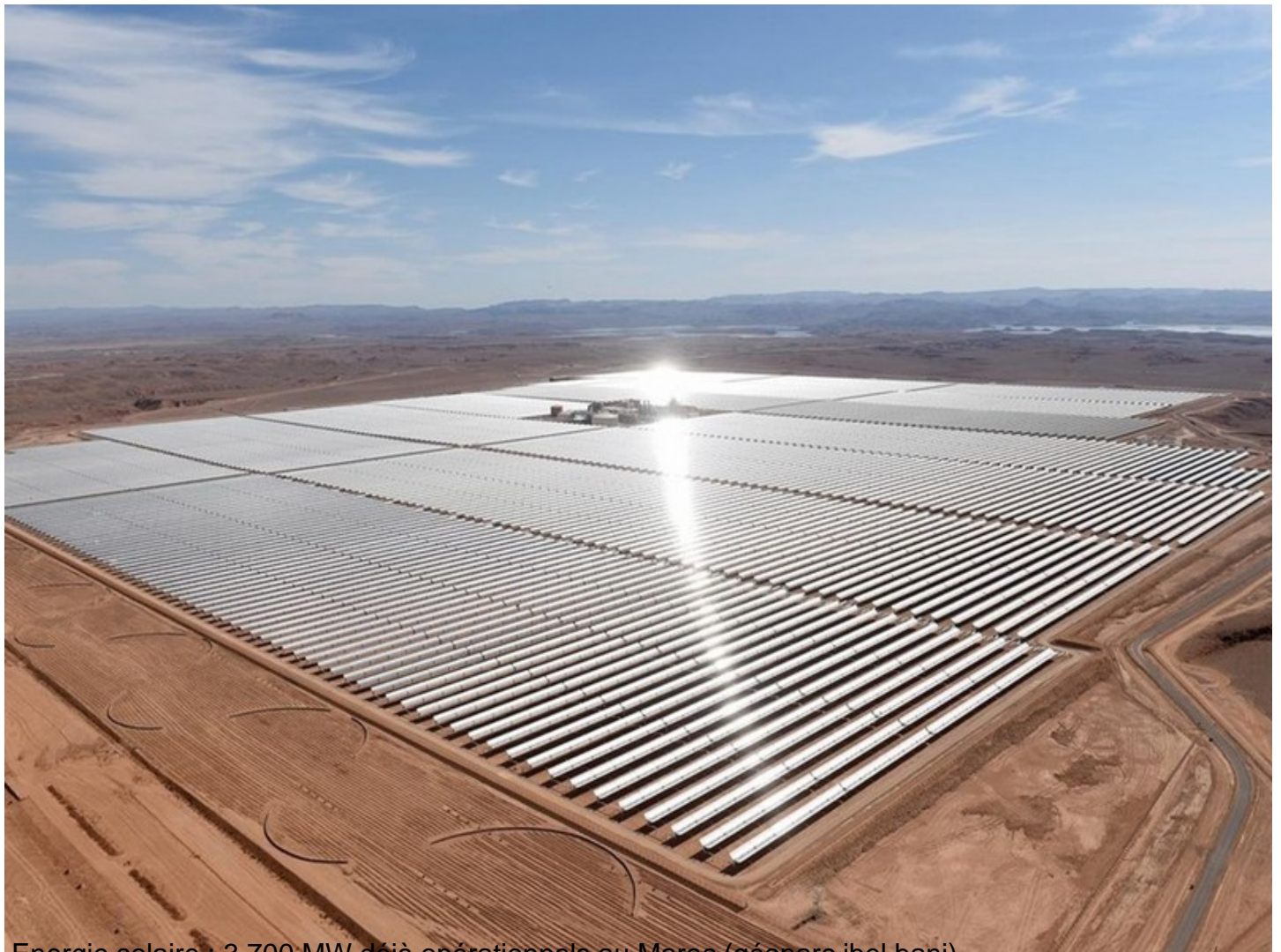
Energie solaire : 3 700 MW déjà opérationnels au Maroc (géoparc jbel bani)
