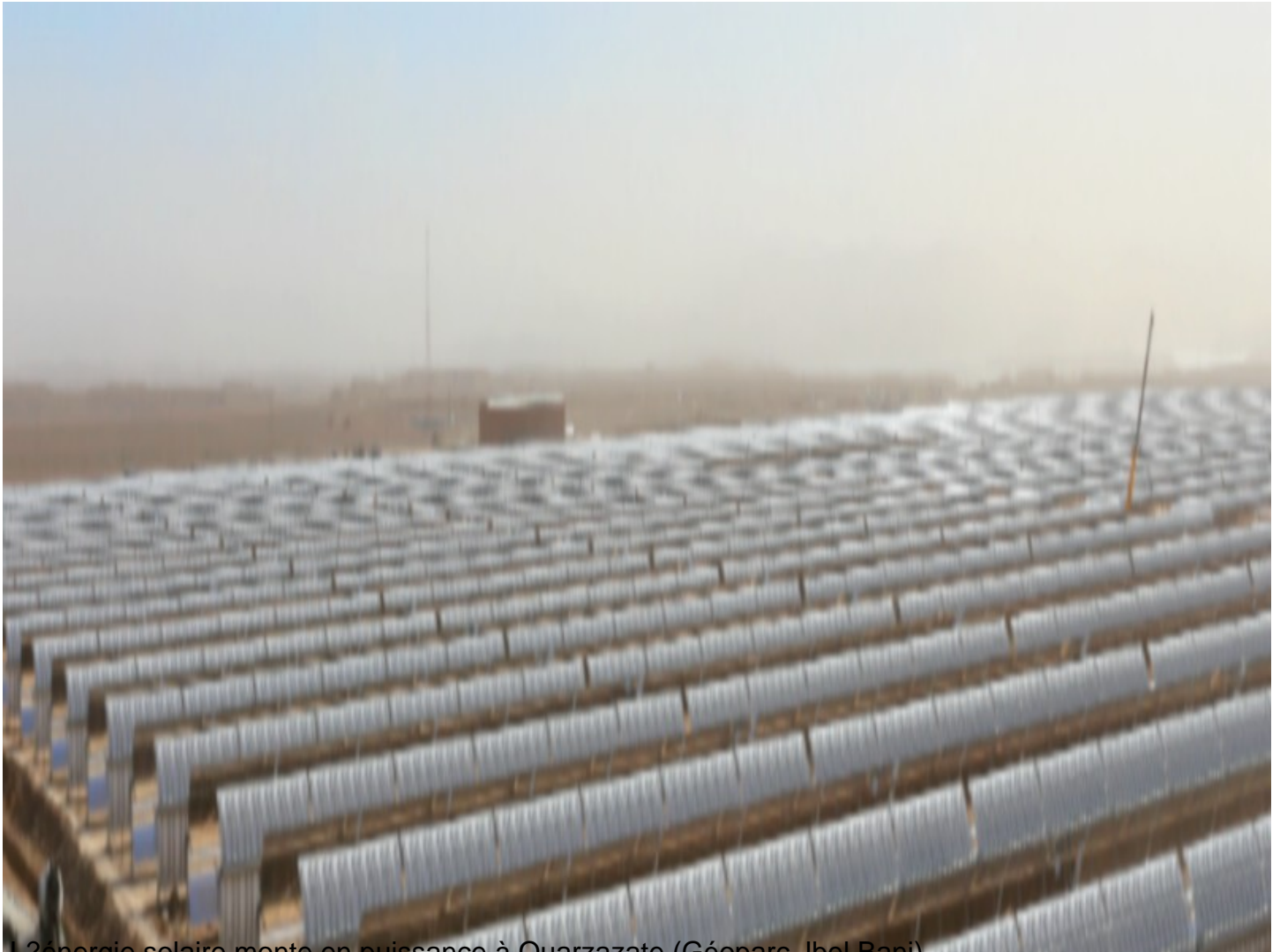
L'énergie solaire monte en puissance à Ouarzazate (Géoparc Jbel Bani)
