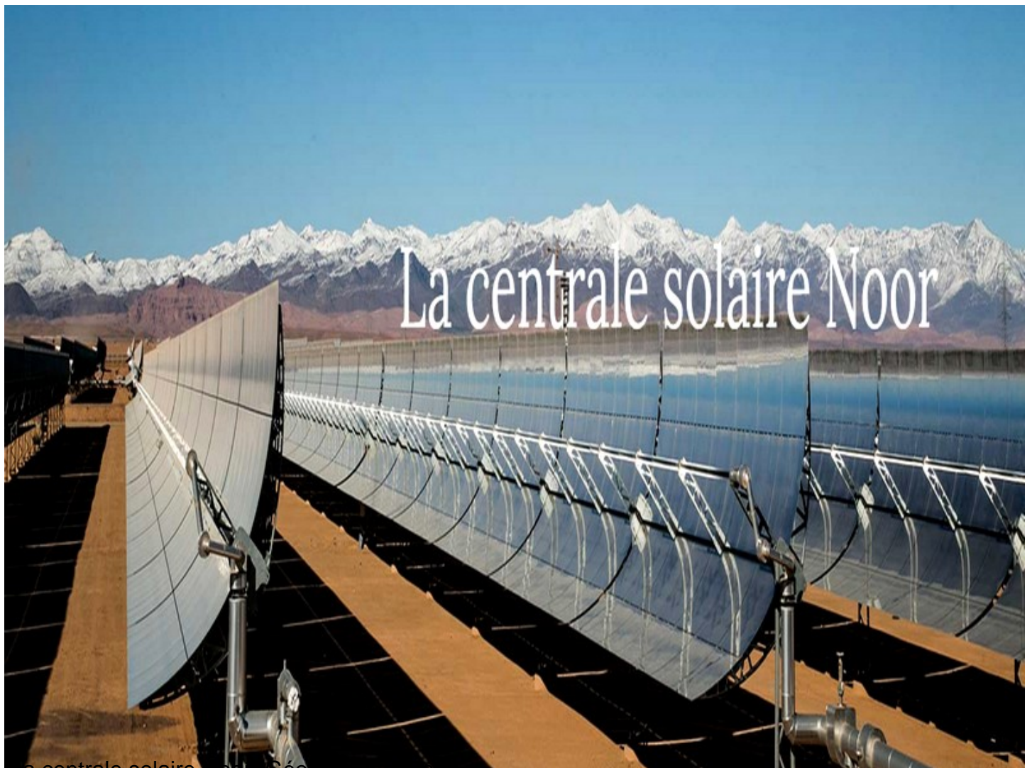
La centrale solaire Noor (Géoparc Jbel Bani)
