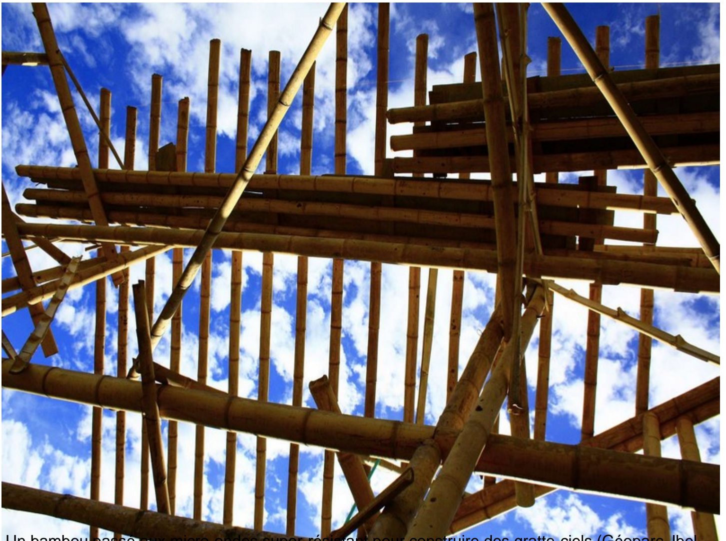
Un bambou passé aux micro-ondes super-résistant pour construire des gratte-ciels (Géoparc Jbel Bani)
