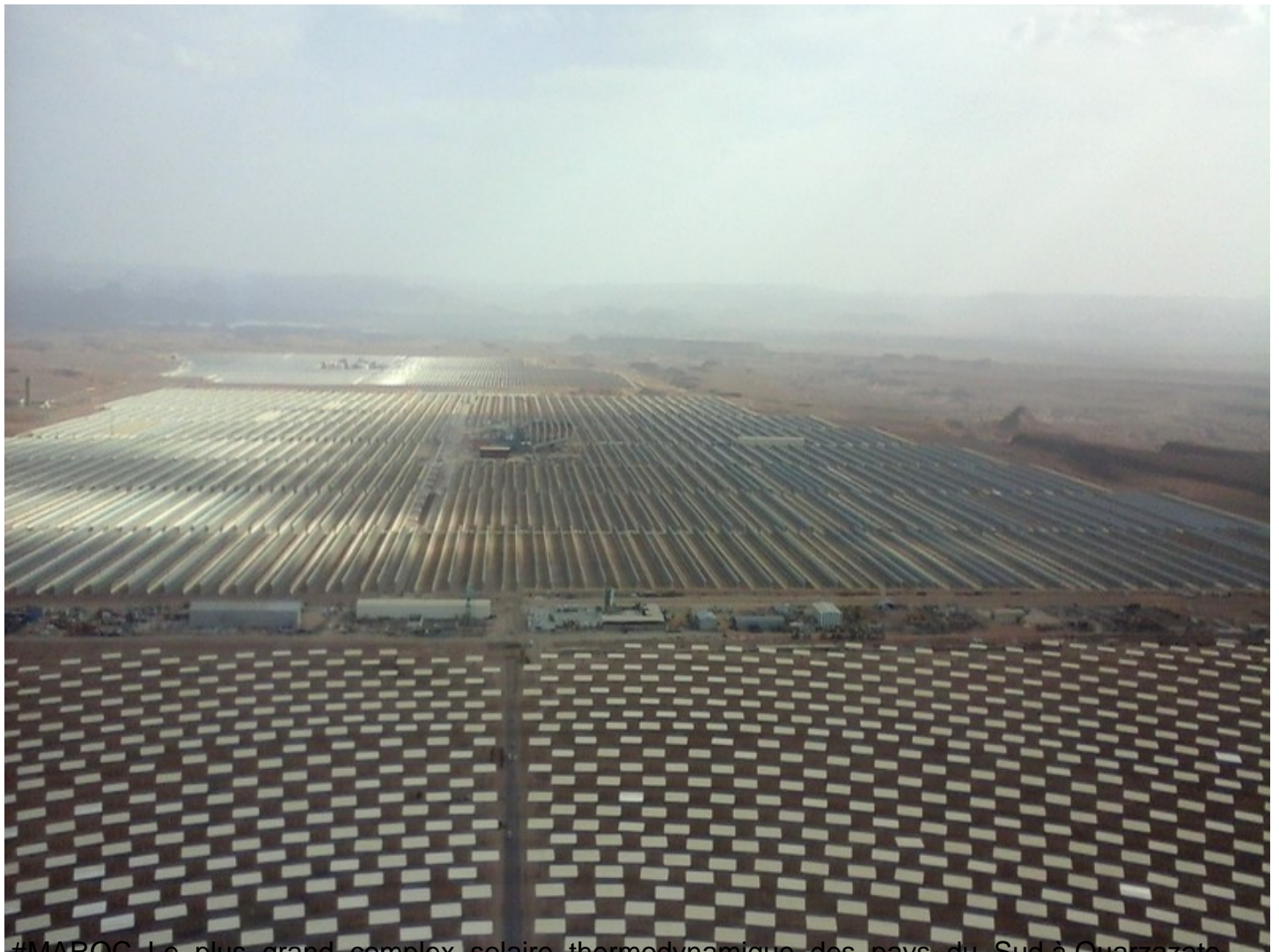
#MAROC_Le_plus_grand_complex_solaire_thermodynamique_des_pays_du_Sud à Ouarzazate
