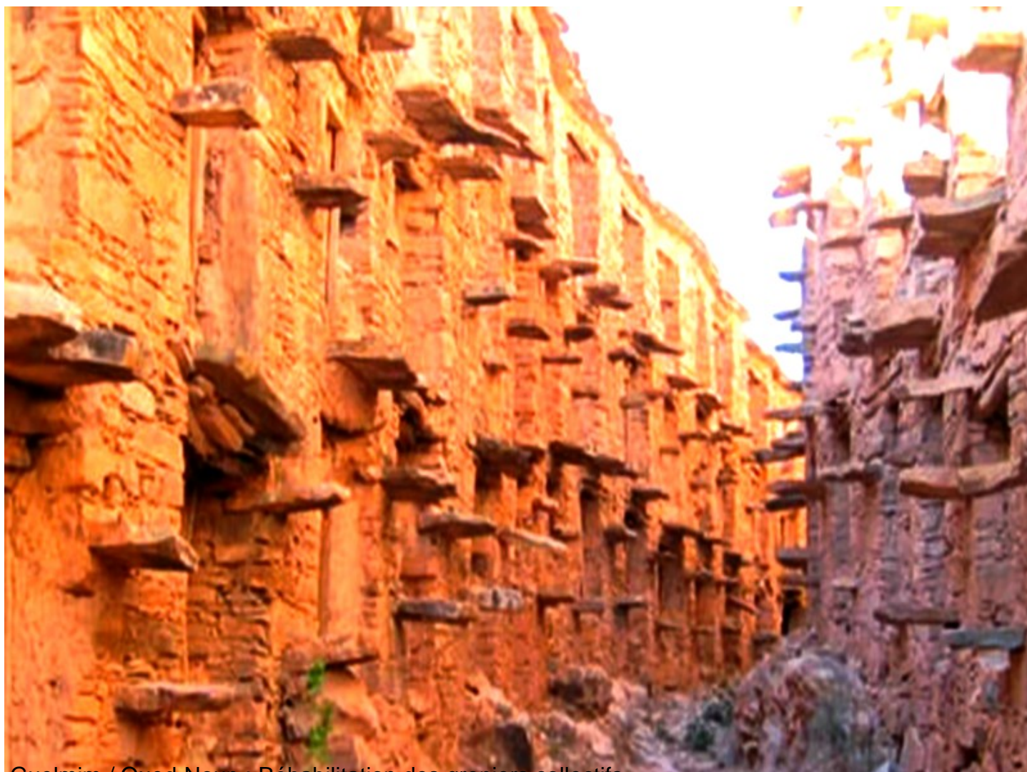
Guelmim / Oued-Noun : Réhabilitation des greniers collectifs
