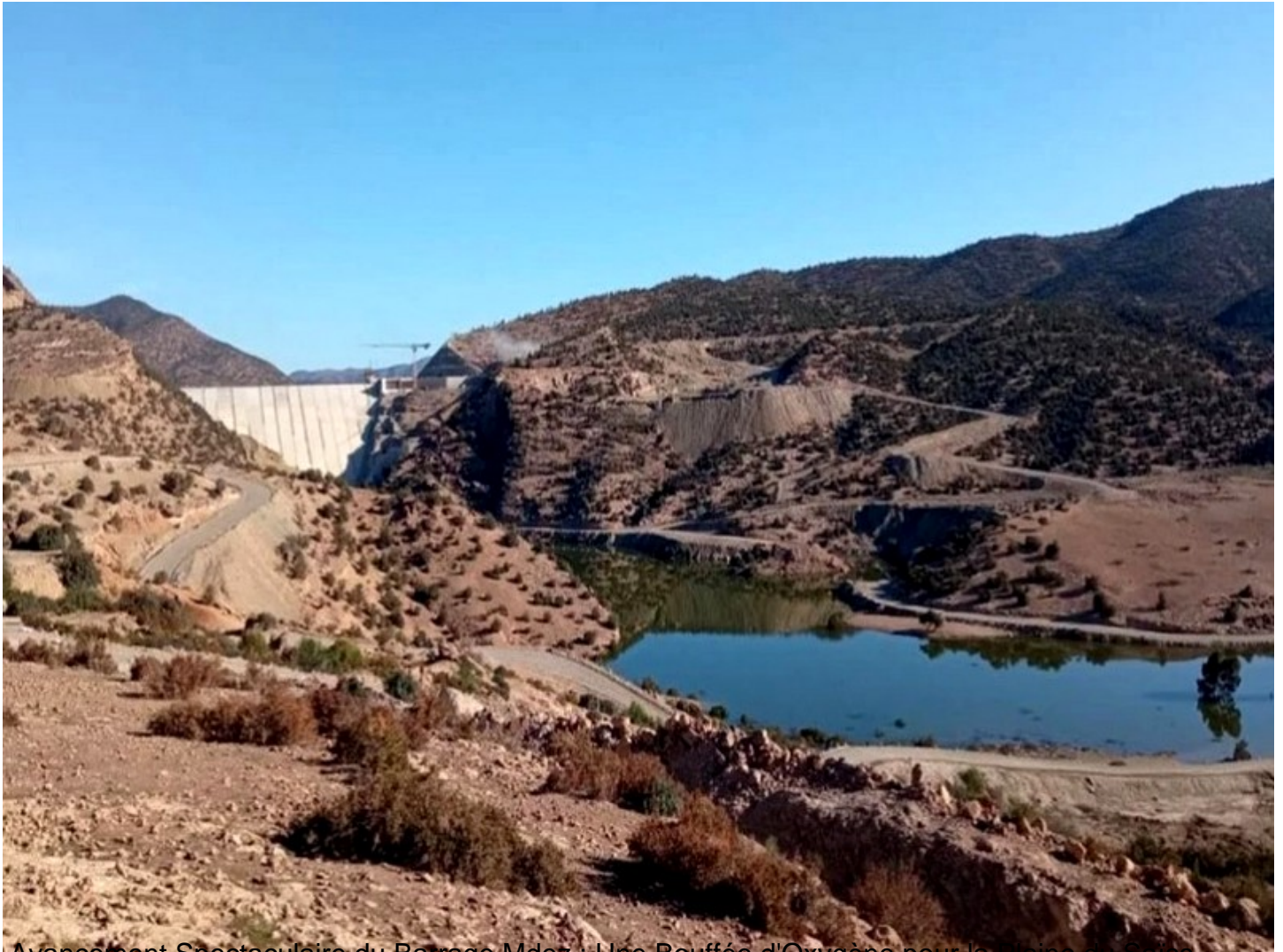
Avancement Spectaculaire du Barrage Mdez : Une Bouffée d'Oxygène pour la Plaine du Saïss
