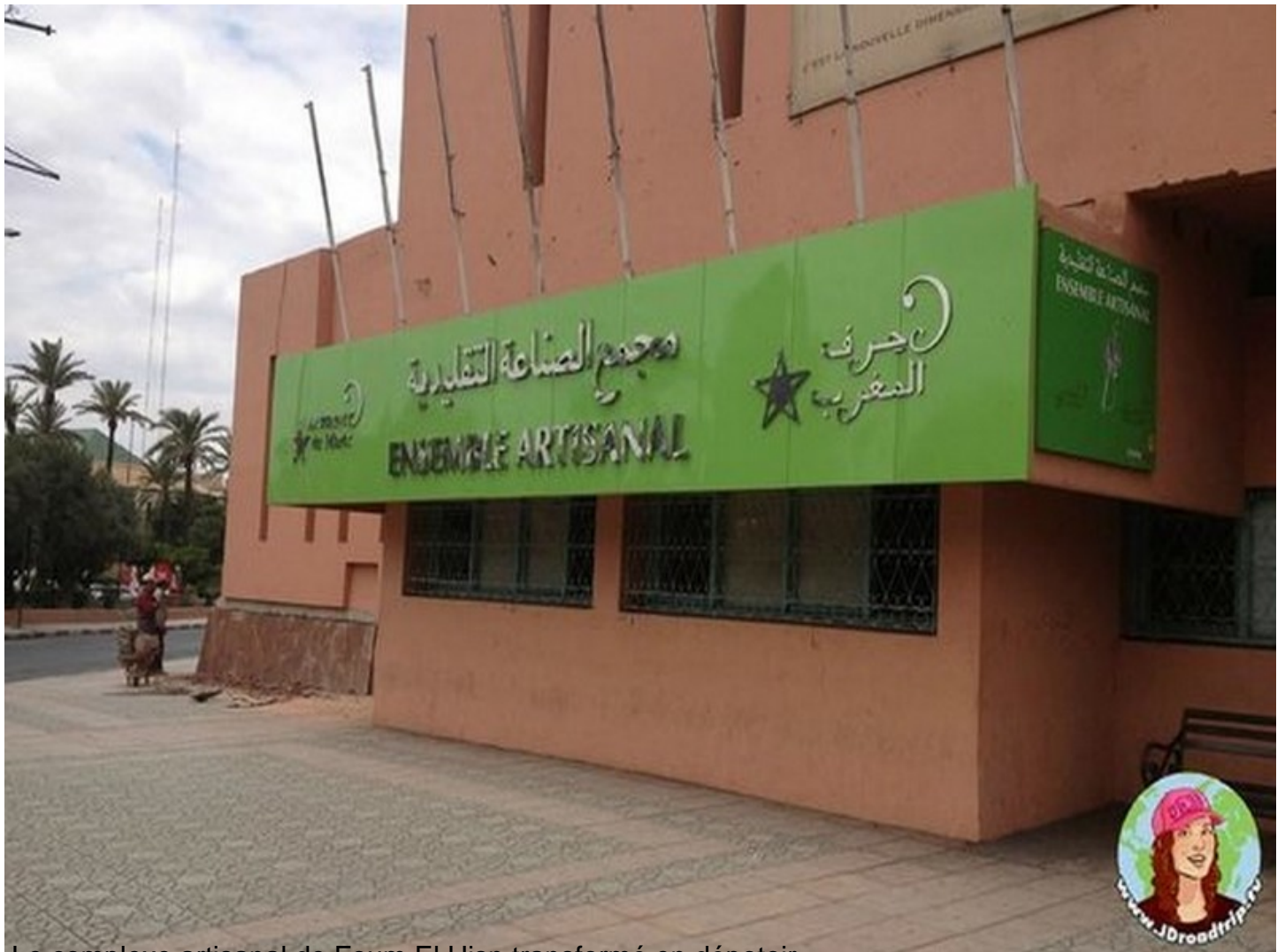
Le complexe artisanal de Foug El Hisn transformé en dépôt
