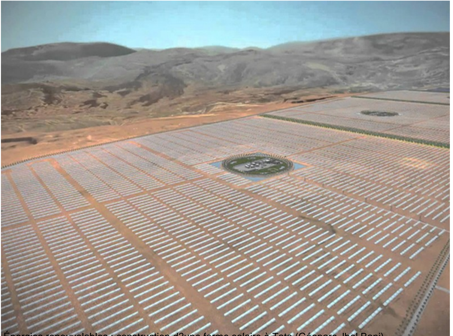
Énergies renouvelables : construction d'une ferme solaire à Tata (Géoparc Jbel Bani)
