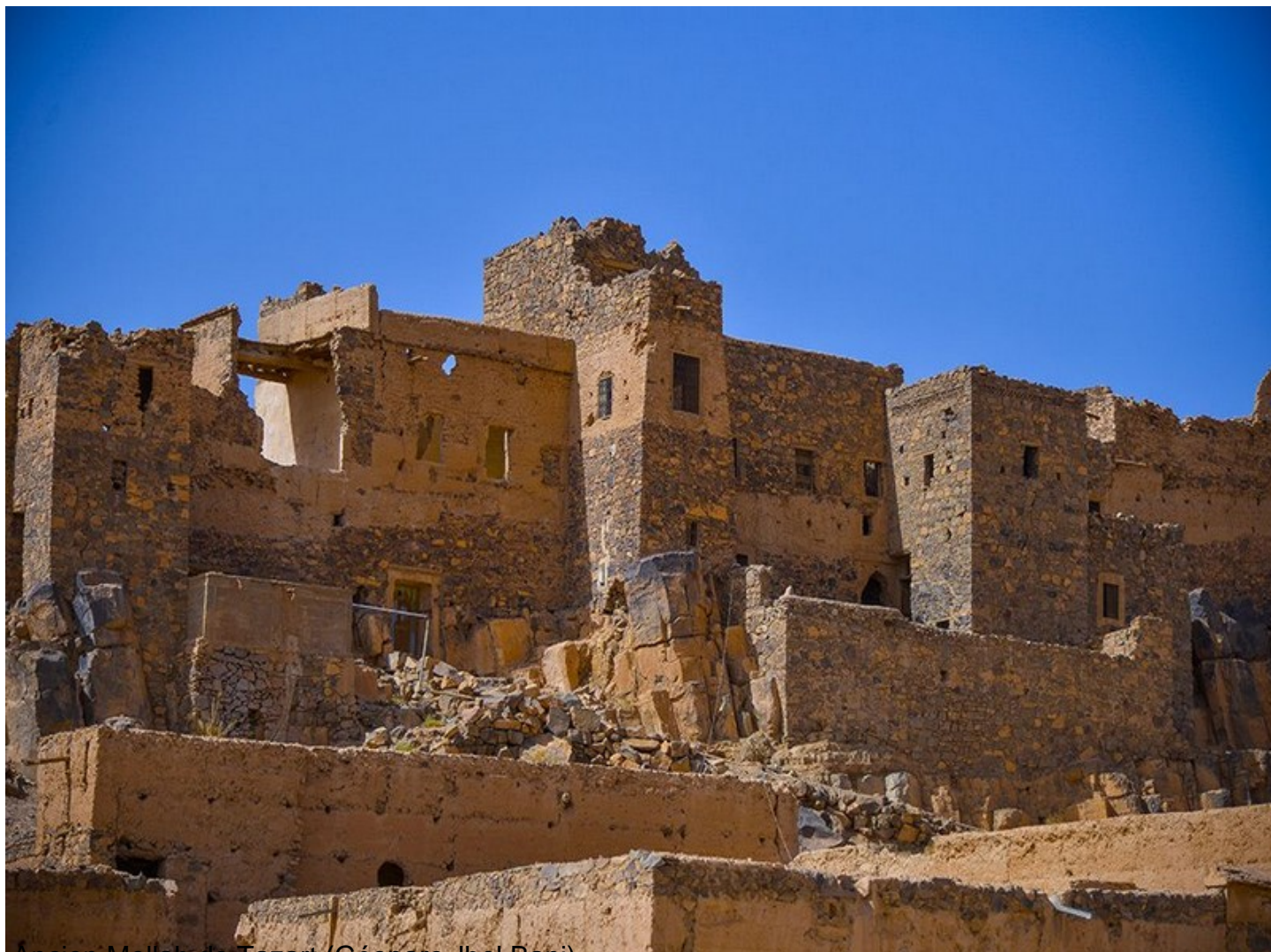
Ancien Mellah de Tazart (Géoparc Jbel Bani)
