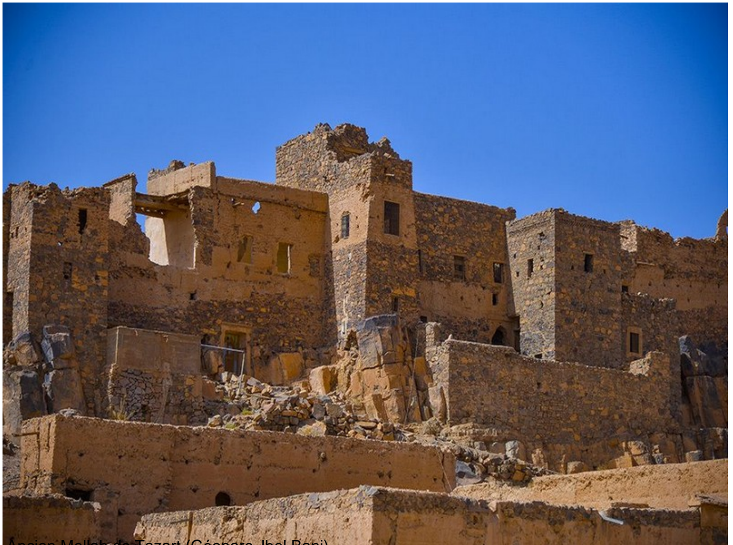
Ancien Mellah de Tazart (Géoparc Jbel Bani)
