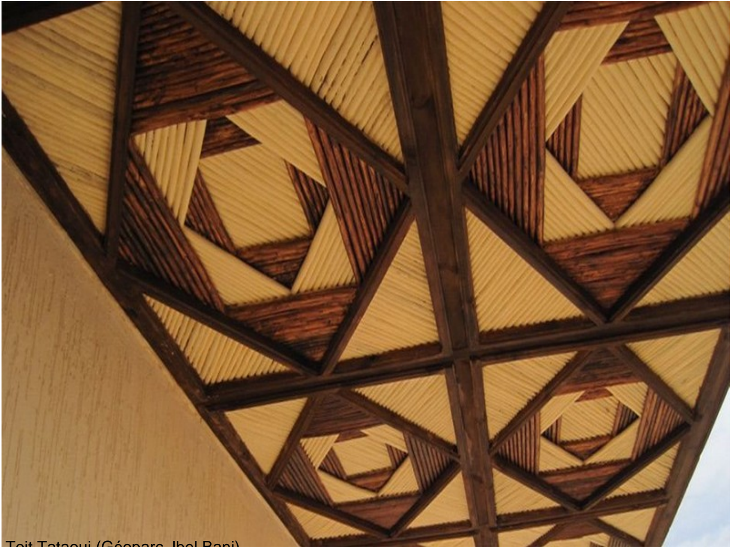
Toit Tataoui (Géoparc Jbel Bani)
