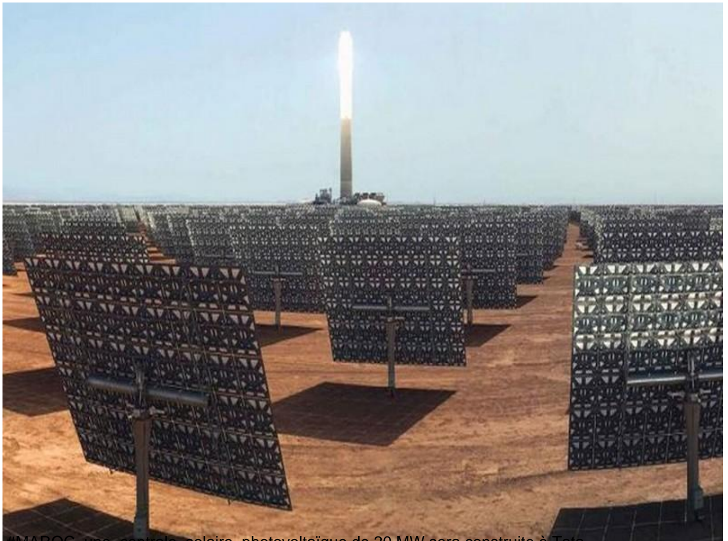
#MAROC_une_centrale_solaire_photovoltaïque de 20 MW sera construite à Tata
