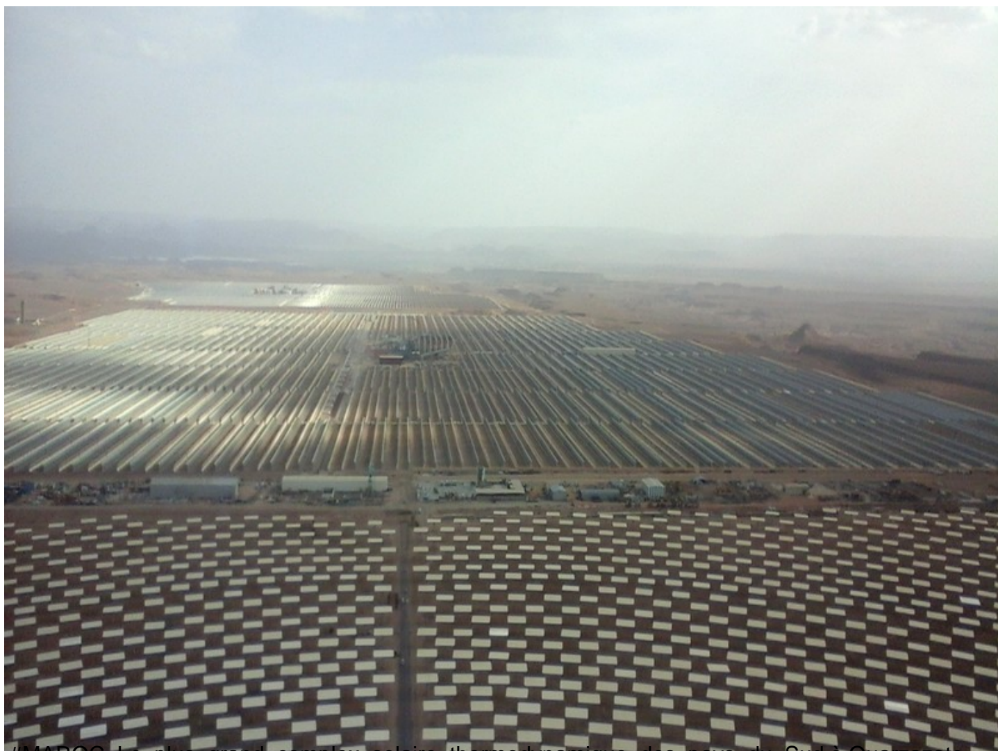
#MAROC_Le_plus_grand_complex_solaire_thermodynamique_des_pays_du_Sud à Ouarzazate
