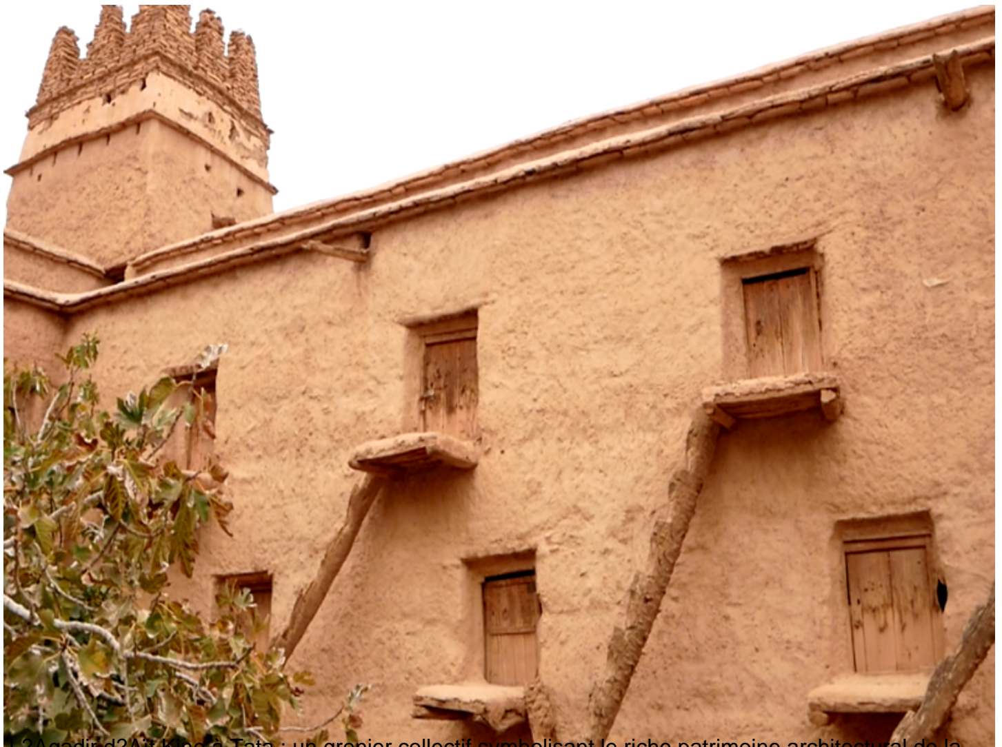
L'Agadir d'Aït Kine à Tata : un grenier collectif symbolisant le riche patrimoine architectural de la région
