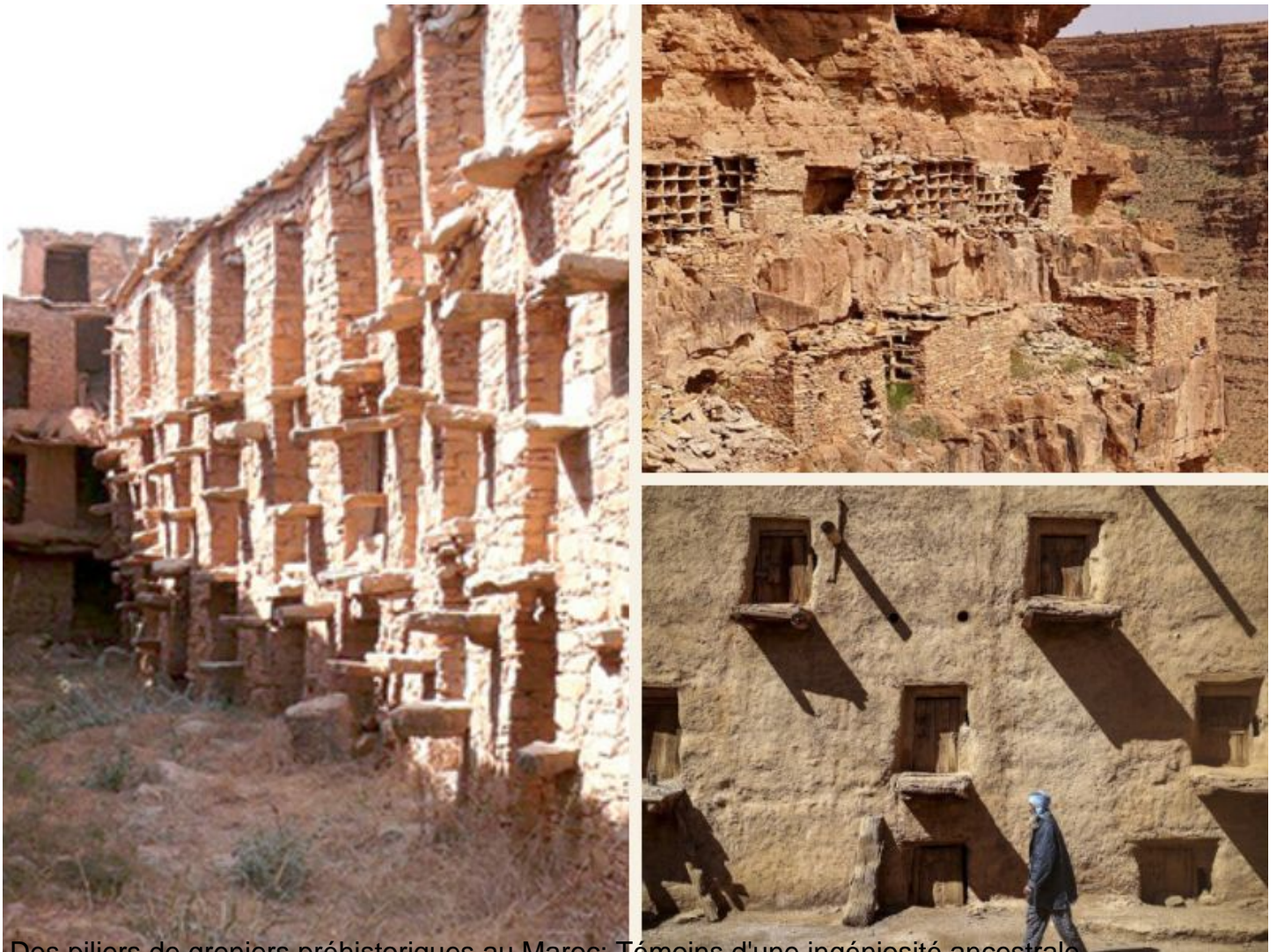
Des piliers de greniers préhistoriques au Maroc: Témoins d'une ingéniosité ancestrale
