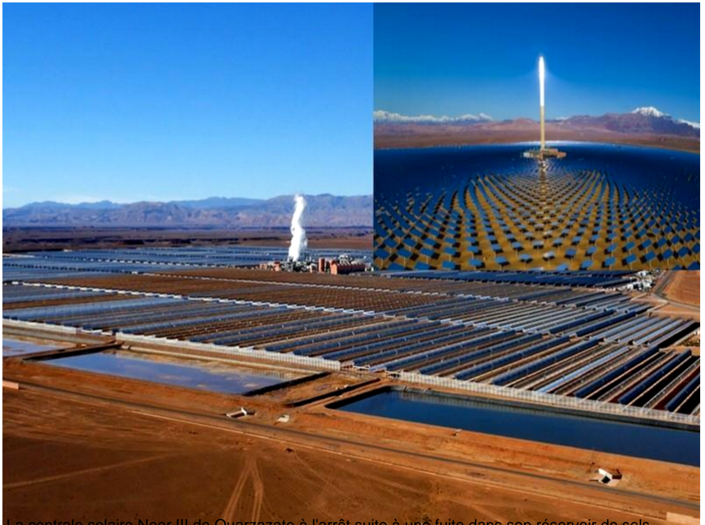
La centrale solaire Noor III de Ouarzazate à l'arrêt suite à une fuite dans son réservoir de sels fondus
