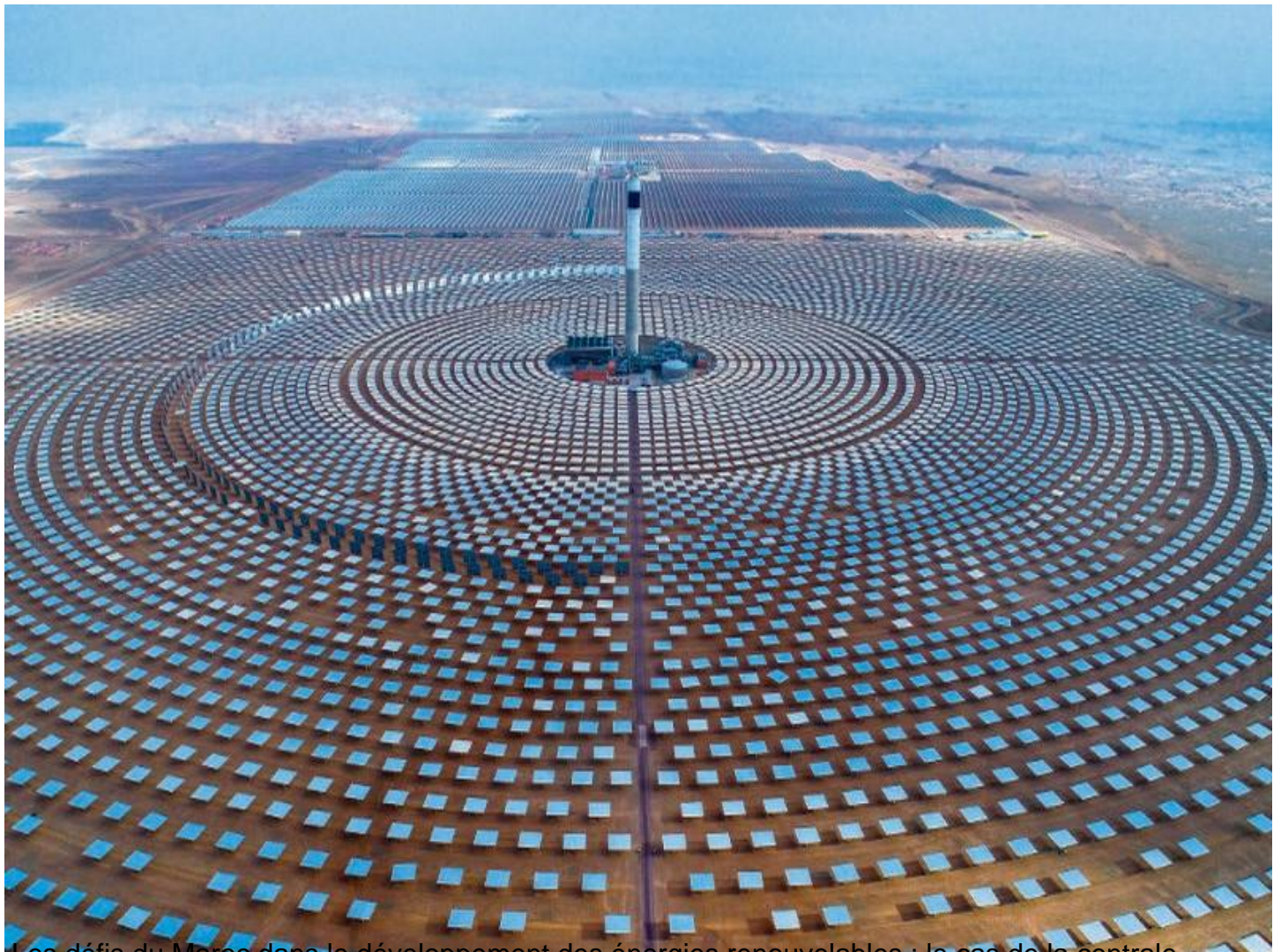
Les défis du Maroc dans le développement des énergies renouvelables : le cas de la centrale solaire Noor Ouarzazate III
