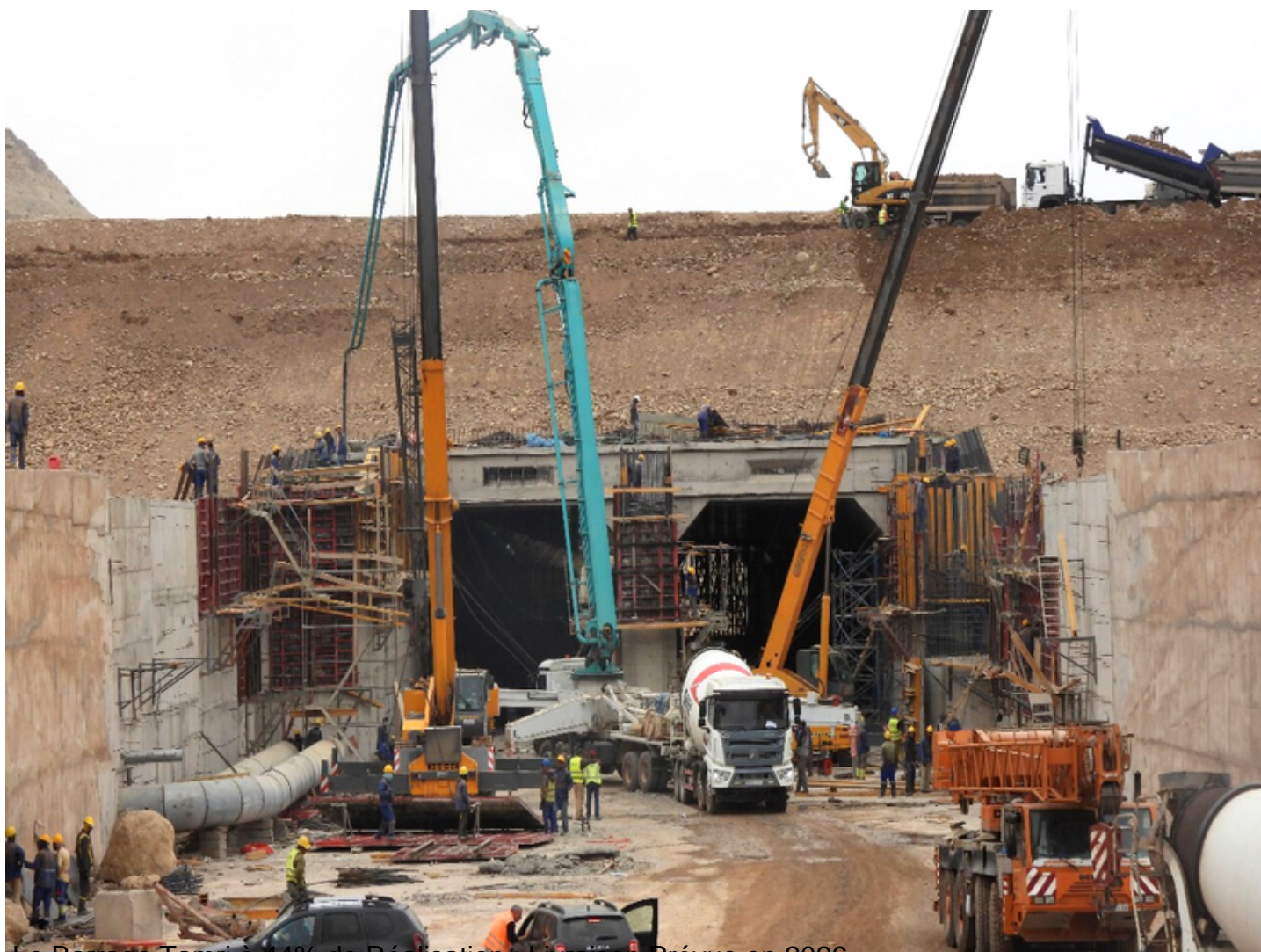
Le Barrage Tamri à 44% de Réalisation : Livraison Prévus en 2026
