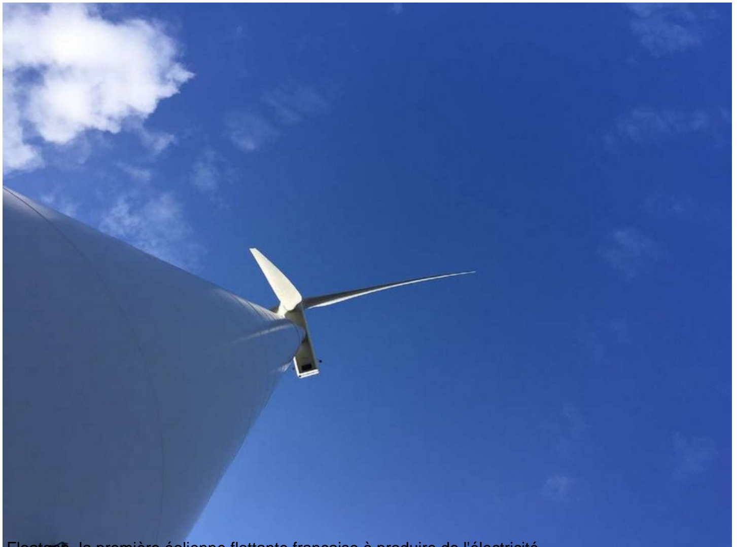
Floatgen, la première éolienne flottante française à produire de l'électricité
