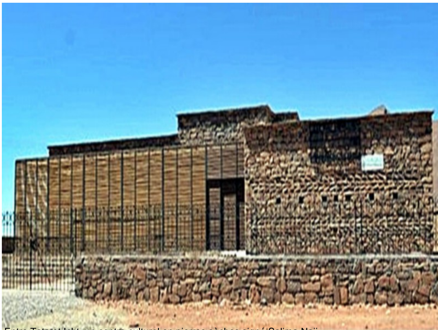
Entre Tata et Icht, un centre culturel en pierres sèches signé Salima Naji
