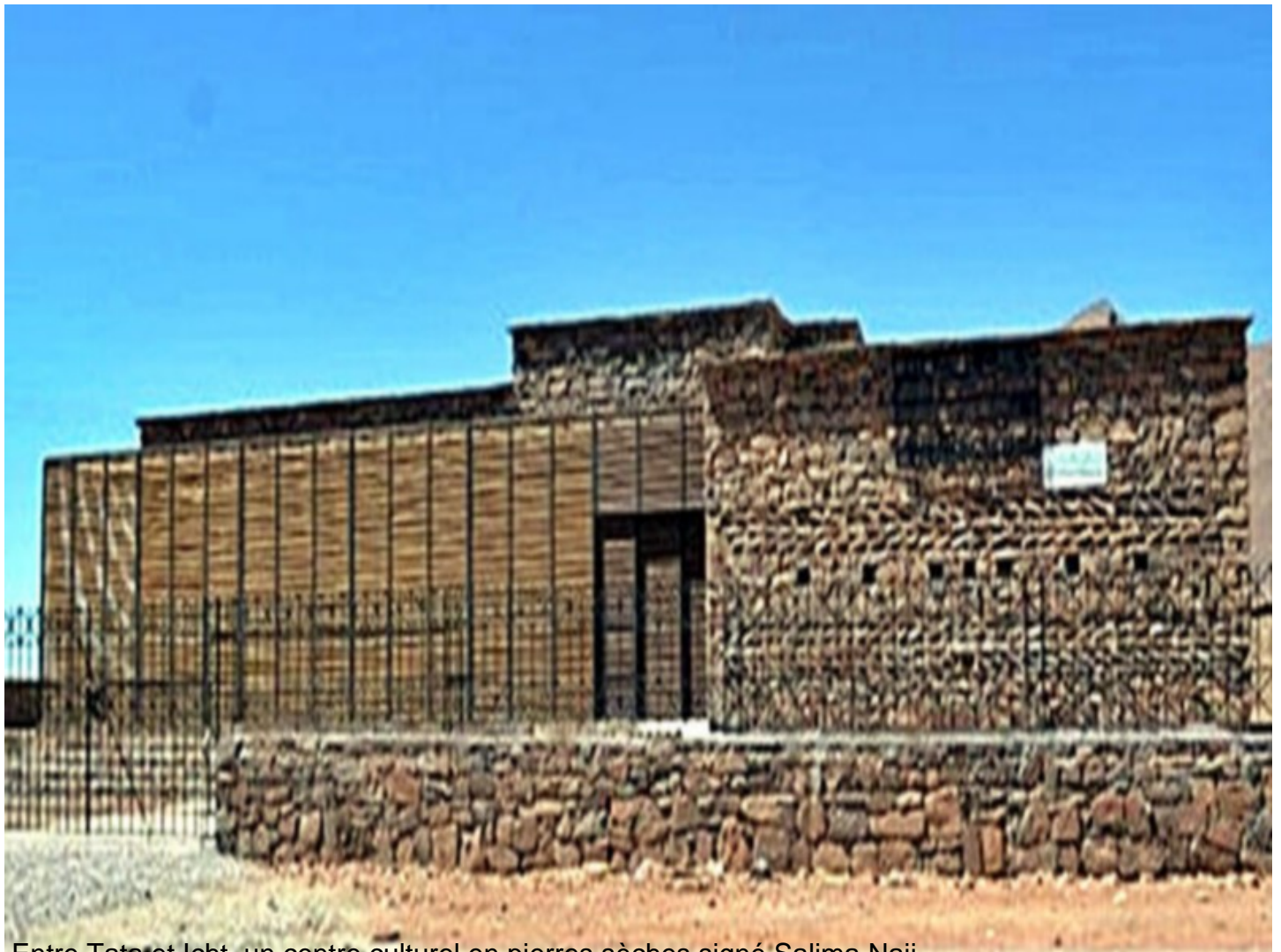
Entre Tata et Icht, un centre culturel en pierres sèches signé Salima Naji
